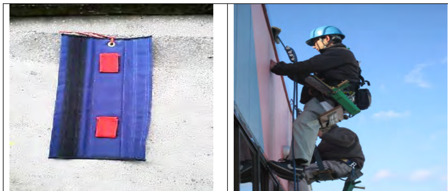
写真9（吊元パラペット部分養生材）
