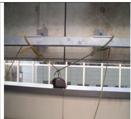
写真17（ツインロープ方式吊元状況）
